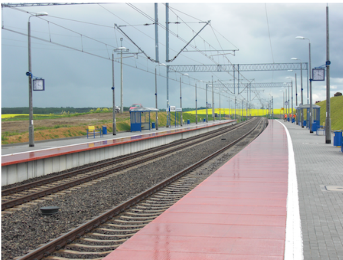
Zdjęcie 9. Perony przystanku kolejowego Młeczewo
