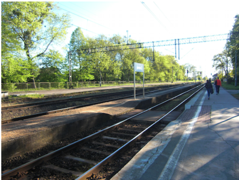
Zdjęcie 6. Perony stacji kolejowej Stare Pole
