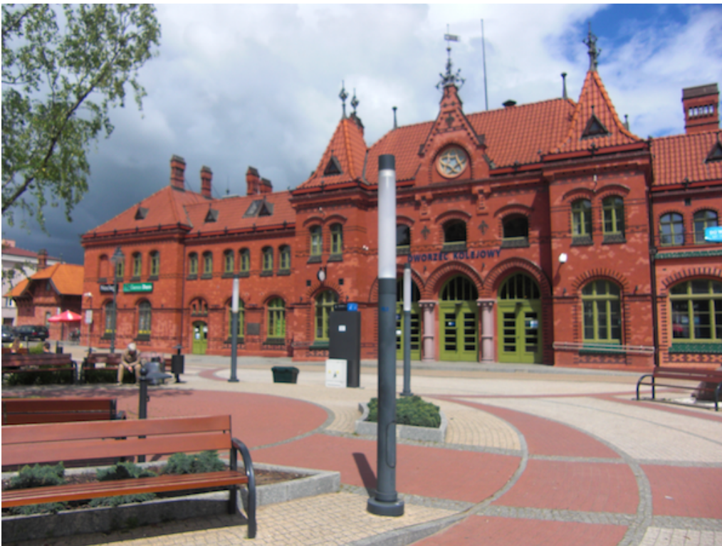
Zdjęcie 1. Dworzec kolejowy Malbork
